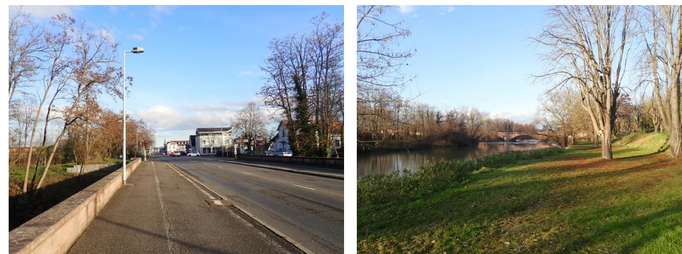
Figure 29. Vues depuis et vers le pont de la RD418
