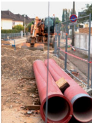
Pilotés par Colmar-Agglomération et la Colmarienne des Eaux, les chantiers de renouvellement des réseaux d'assainissement (désamiantage, démontage et remplacement des conduites, remplacement des raccords individuels) ont avancé régulièrement et sans prendre de retard, en bénéficiant jusqu'ici d'une météo très favorable. Il en a été de même du remplacement du réseau d'eau potable, mené de front avec le chantier d'assainissement.
